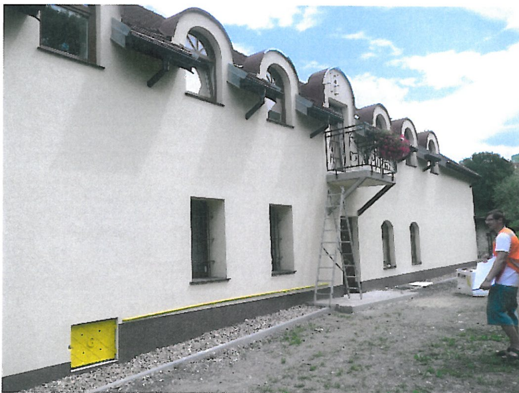
Budynek mieszkalny (elewacja tylna)
