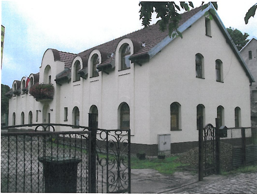
Budynek mieszkalny (elewacja frontowa / boczna – prawa)
