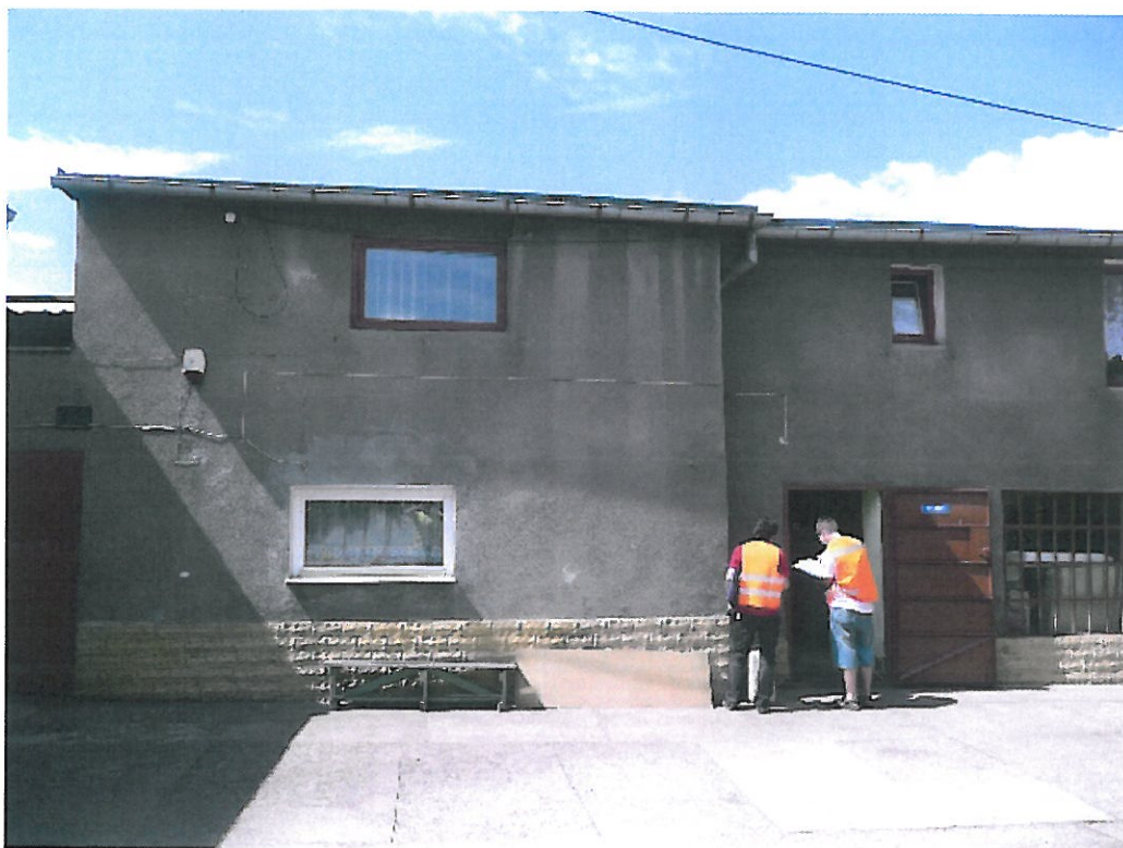
Budynek mieszkalny (elewacja frontowa)
