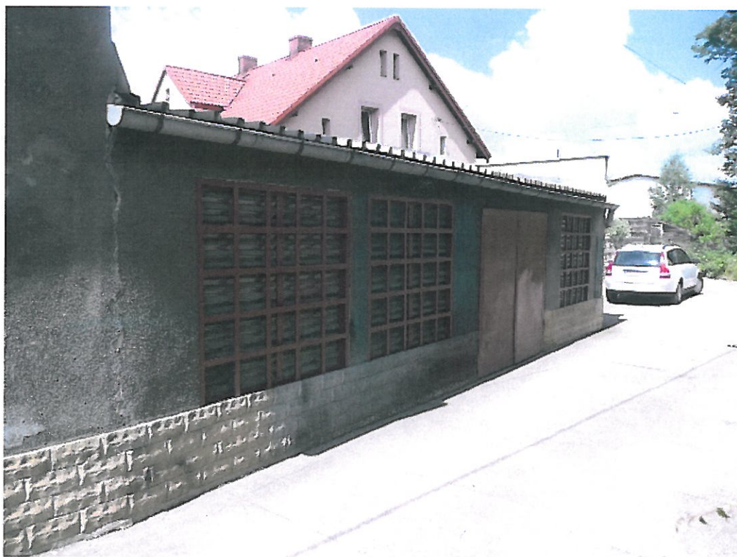
Budynek gospodarczy (elewacja frontowa)
