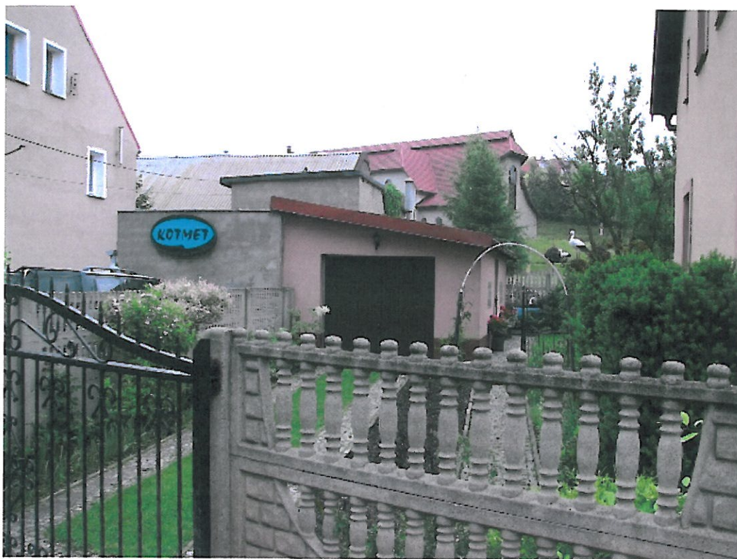
Budynek gospodarczy (elewacja frontowa)
