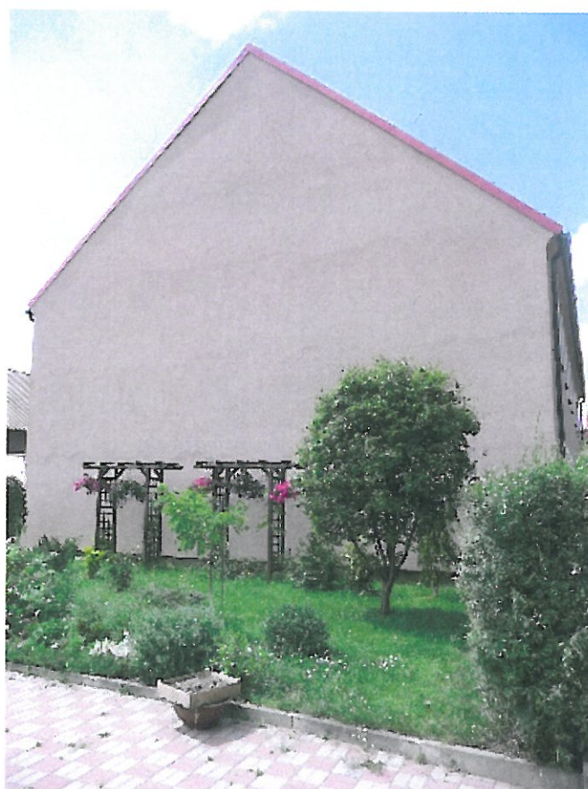
Budynek mieszkalny (elewacja boczna - lewa)
