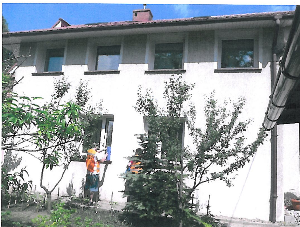
Budynek mieszkalny (elewacja tylna)
