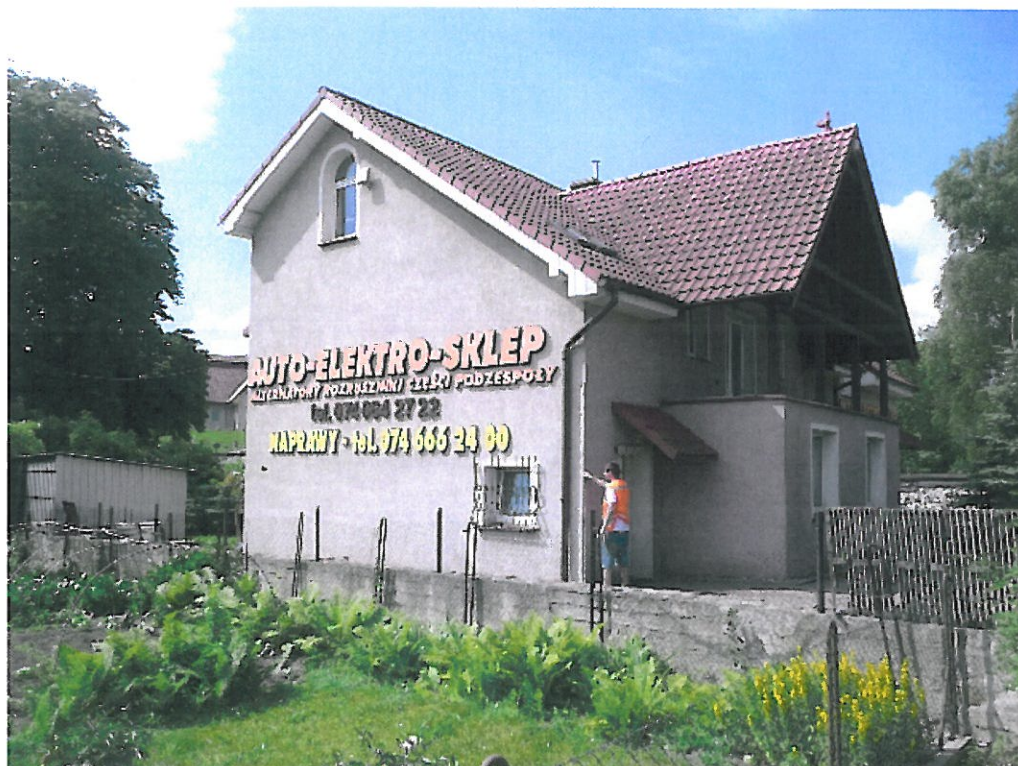
Budynek mieszkalny (elewacja boczna - lewa)
