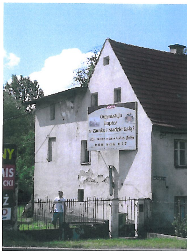
Budynek mieszkalny (elewacja boczna - lewa)
