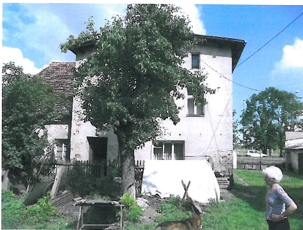
Budynek mieszkalny (elewacja tylna)
