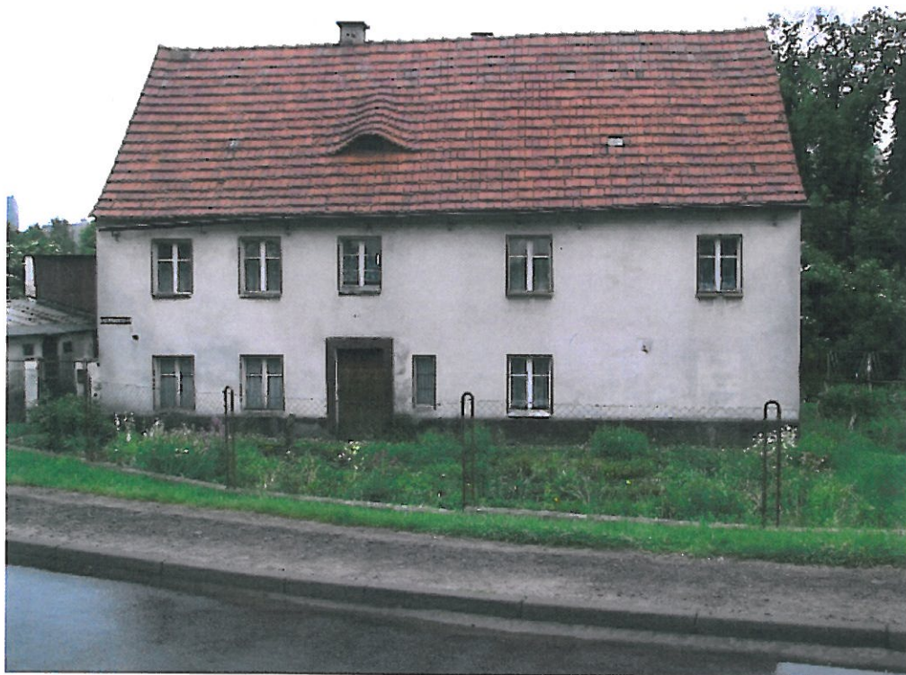
Budynek mieszkalny (elewacja frontowa)
