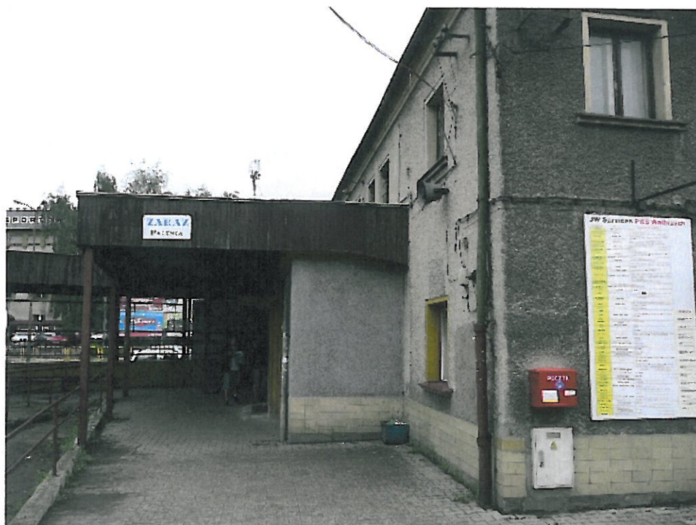
Budynek transportu i łączności / budynek inny (elewacja tylna)
