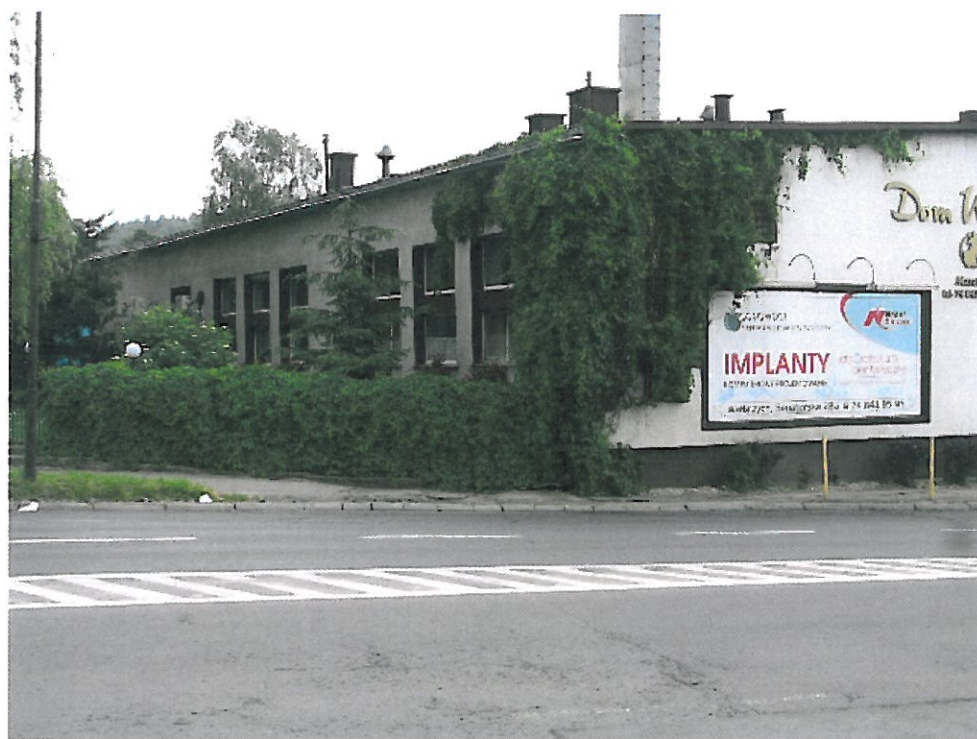
Budynek handlowo – usługowy (elewacja tylna / boczna – lewa)
