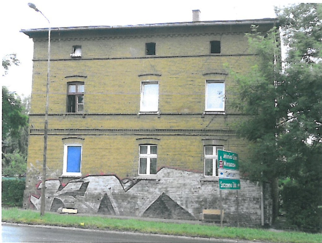
Budynek mieszkalny (elewacja frontowa)
