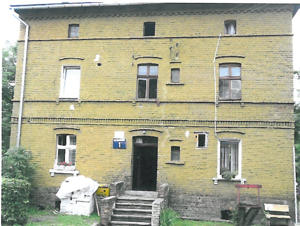
Budynek mieszkalny (elewacja tylna)
