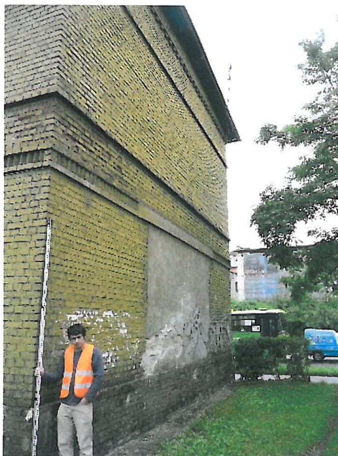
Budynek mieszkalny (elewacja boczna – lewa)
