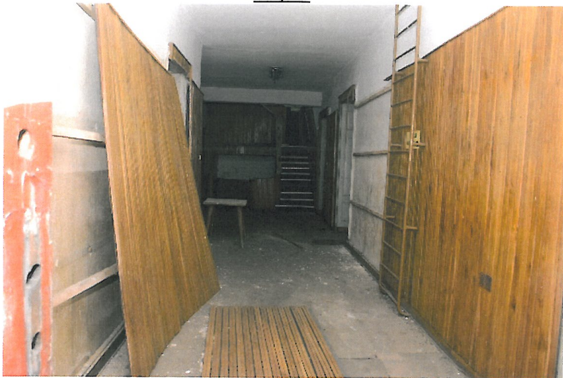
II piętro – korytarz główny
