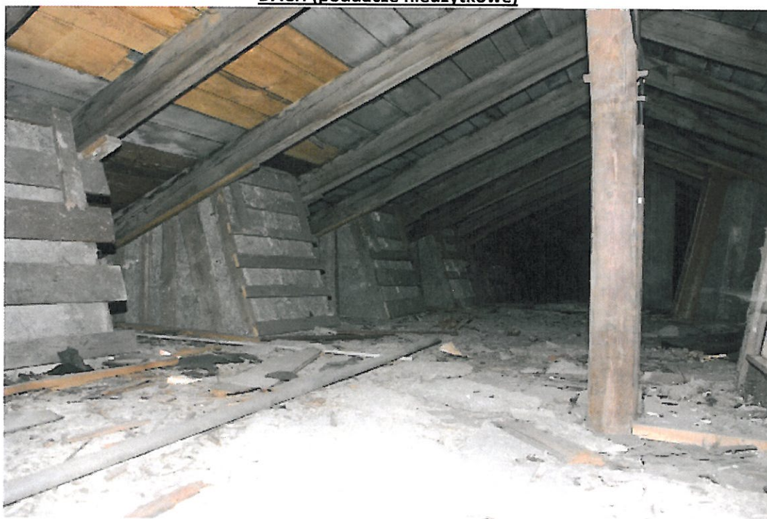
Dach - elementy konstrukcyjne (podparcie płatów nośnych)
