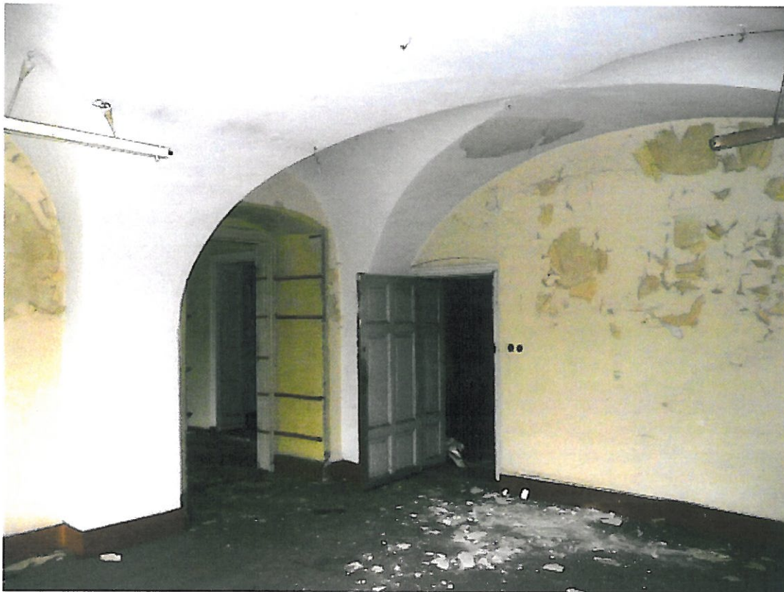
I piętro – pomieszczenie użytkowe
