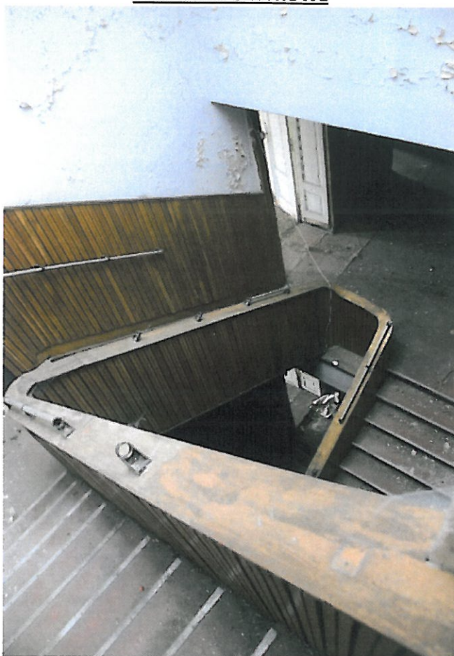
Poddasze – widok klatki schodowe
