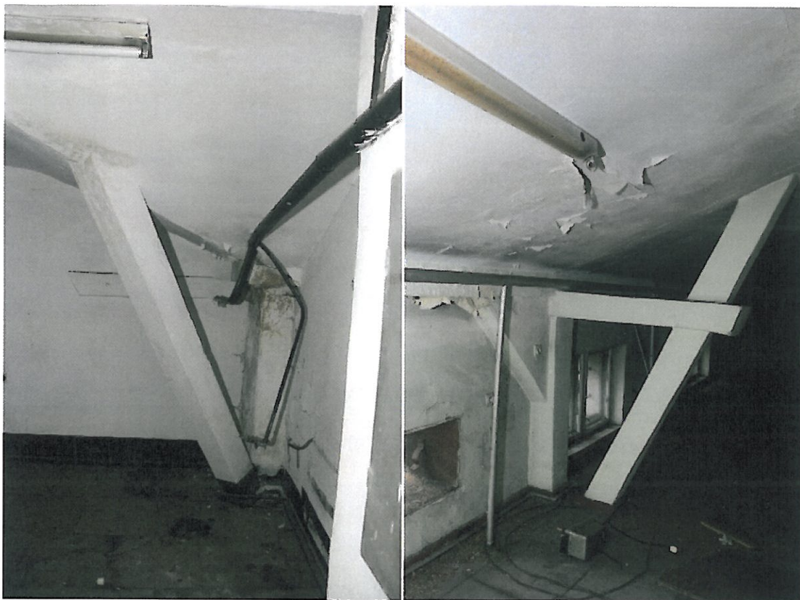
Poddasze – elementy konstrukcyjne (podparcie belek kosza dachowego, krokwi i murłat)
