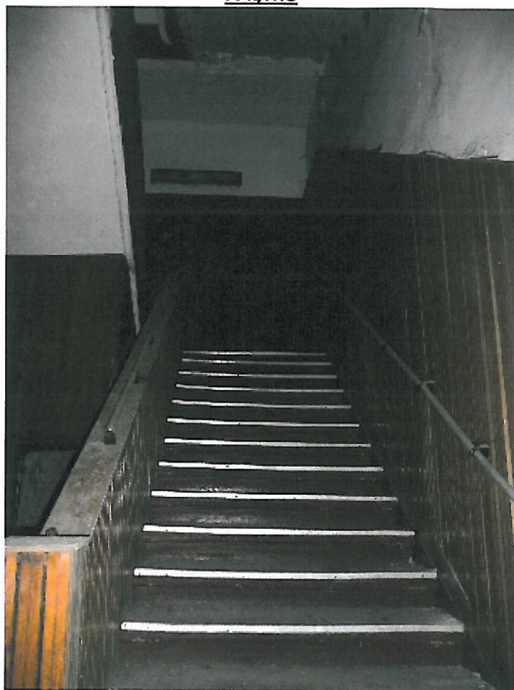
I, II piętro – schody
