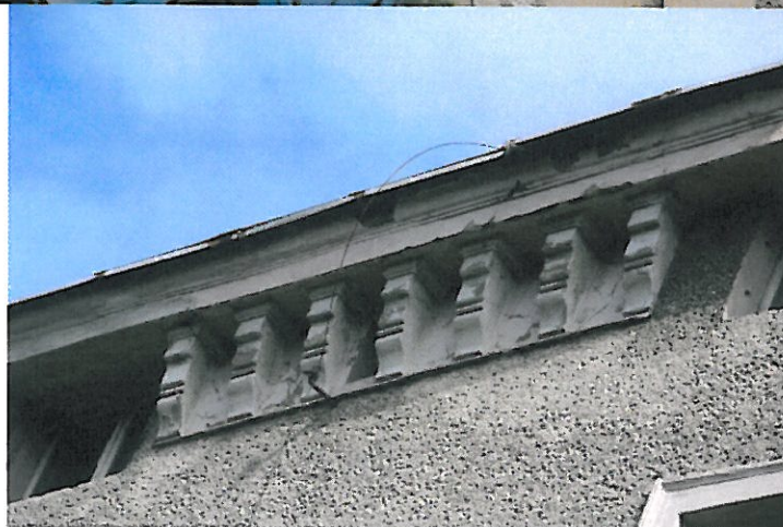
Elewacja – szczegóły architektoniczne
