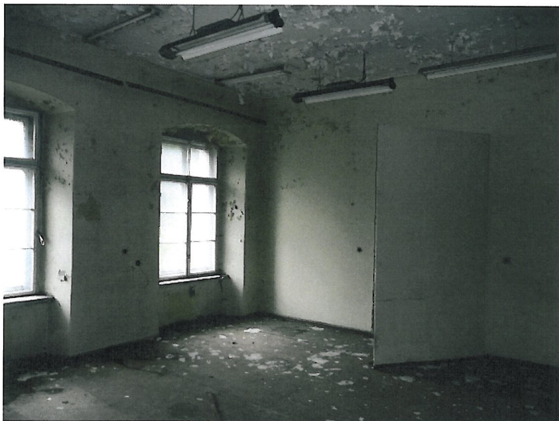
I piętro – pomieszczenie użytkowe
