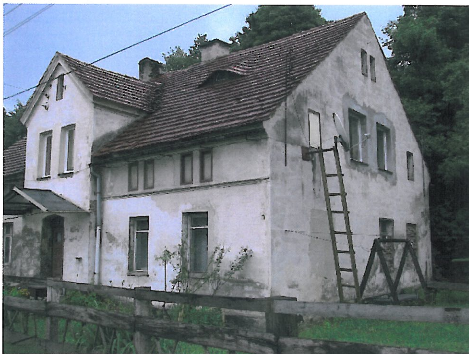
Budynek mieszkalny (elewacja frontowa / boczna - prawa)
