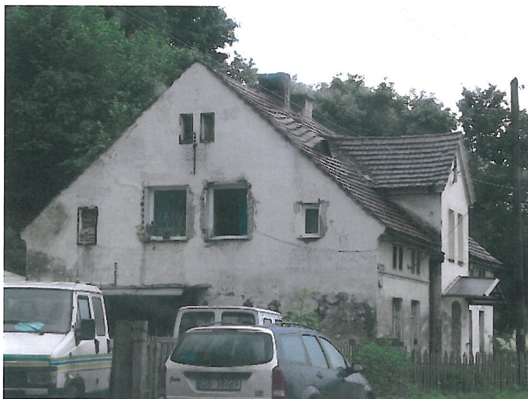
Budynek mieszkalny (elewacja boczna - lewa)
