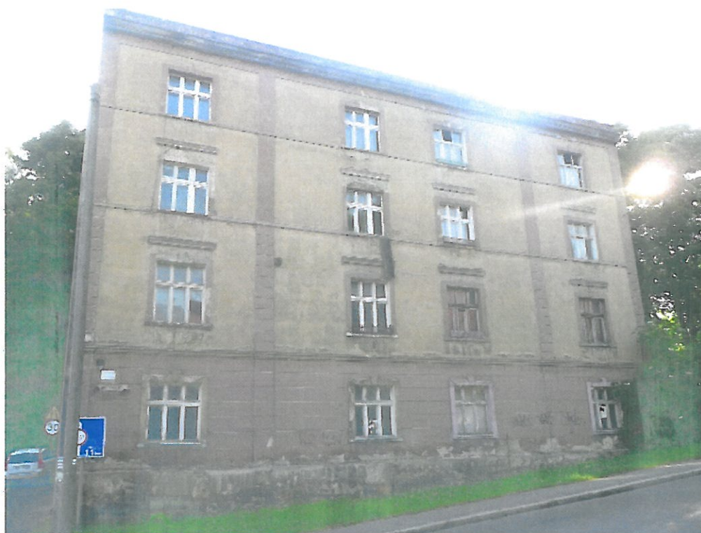
Budynek mieszkalny (elewacja frontowa)
