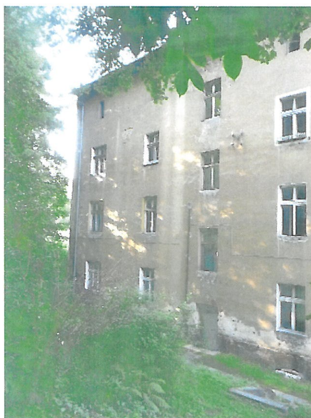
Budynek mieszkalny (elewacja tylna)
