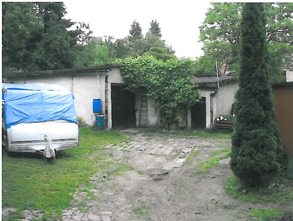
Budynek inny (elewacja frontowa)
