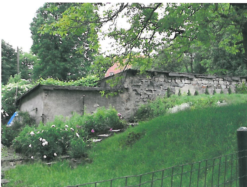
Budynek inny (elewacja tylna)
