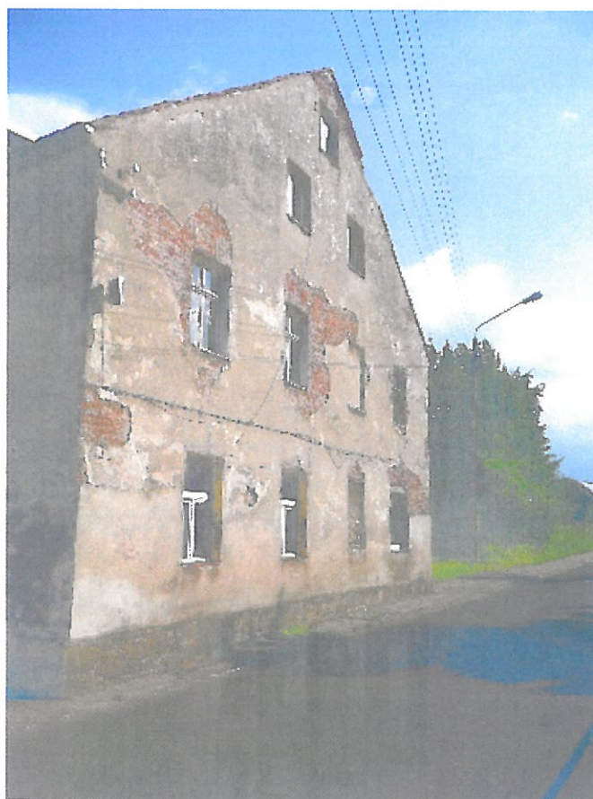
Budynek mieszkalny (elewacja boczna - z ul. 13)
