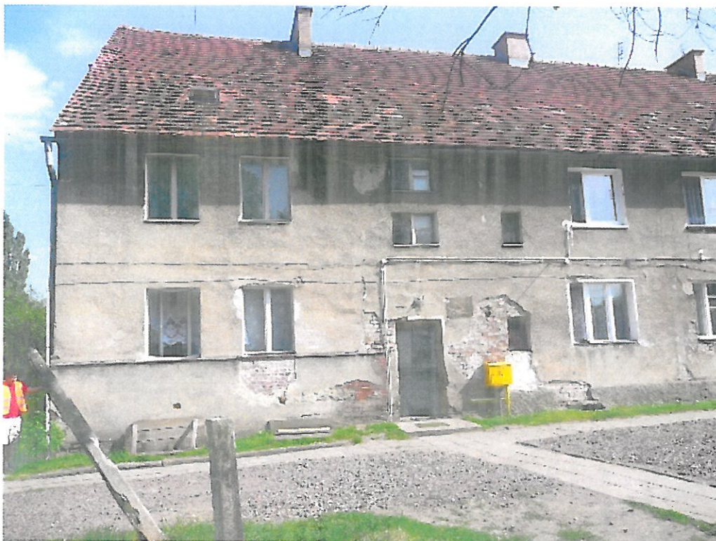
Budynek mieszkalny (elewacja frontowa)
