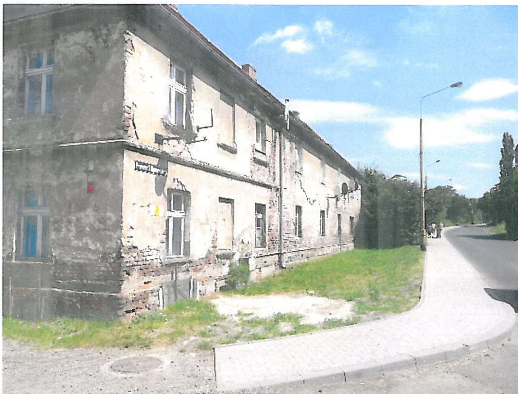
Budynek mieszkalny (elewacja frontowa / boczna – lewa)
