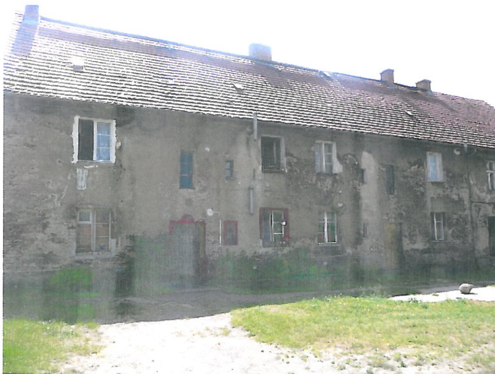
Budynek mieszkalny (elewacja tylna)
