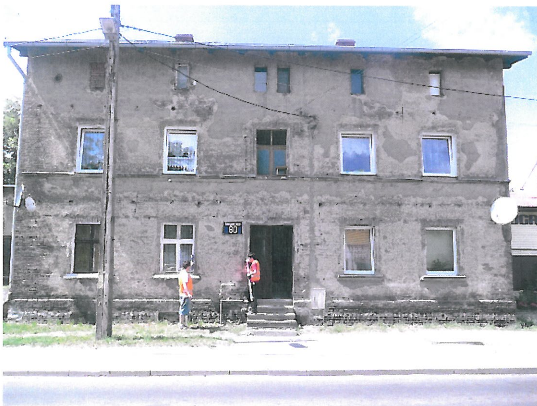
Budynek mieszkalny (elewacja frontowa)
