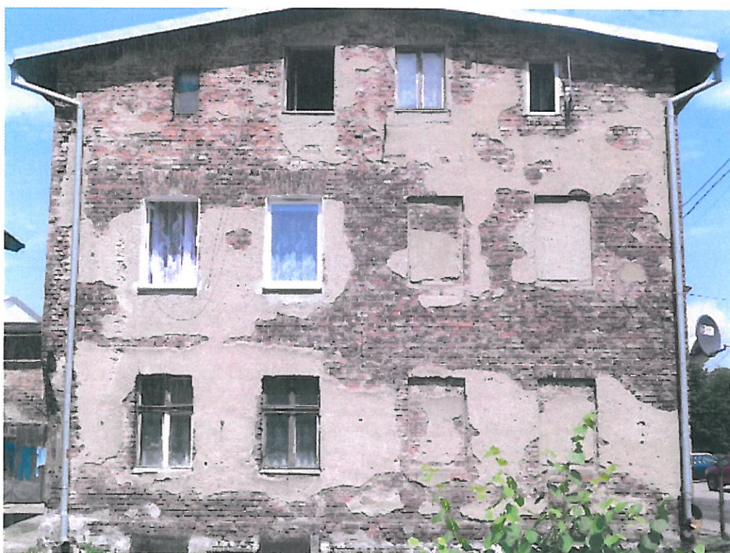
Budynek mieszkalny (elewacja boczna – lewa)
