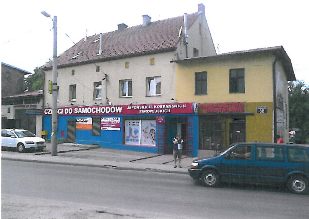
Budynek mieszkalny (elewacja frontowa)
