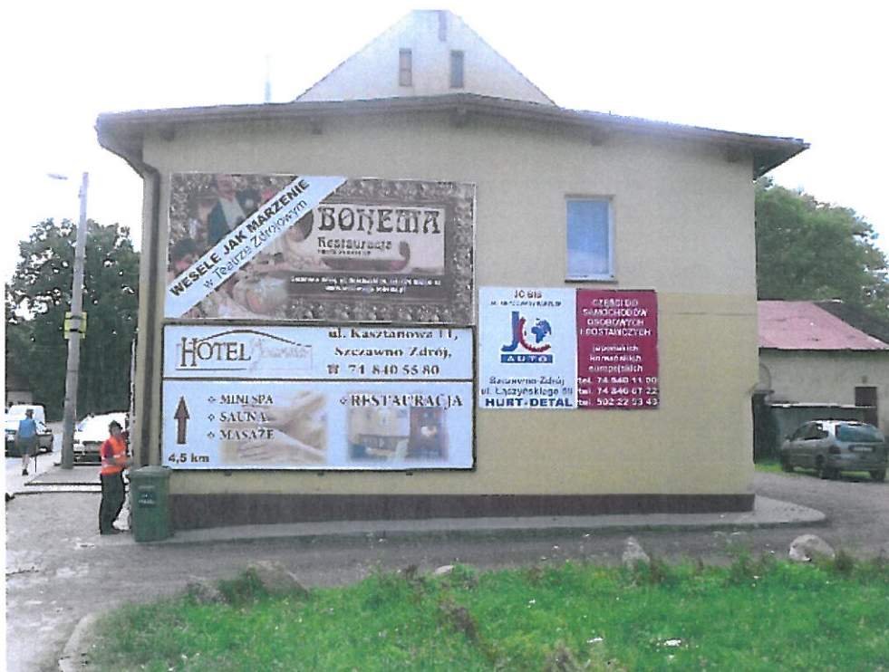
Budynek mieszkalny (elewacja boczna – prawa)
