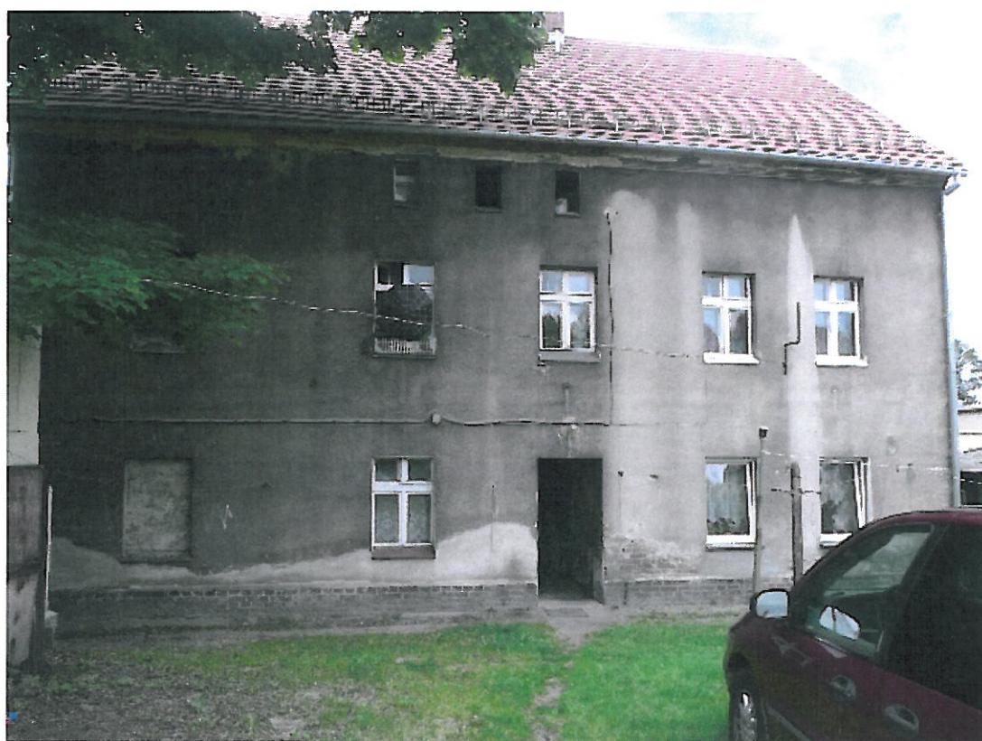
Budynek mieszkalny (elewacja tylna)
