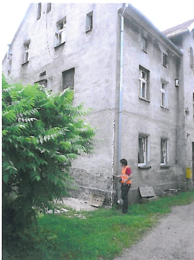
Budynek mieszkalny (elewacja boczna - lewa)
