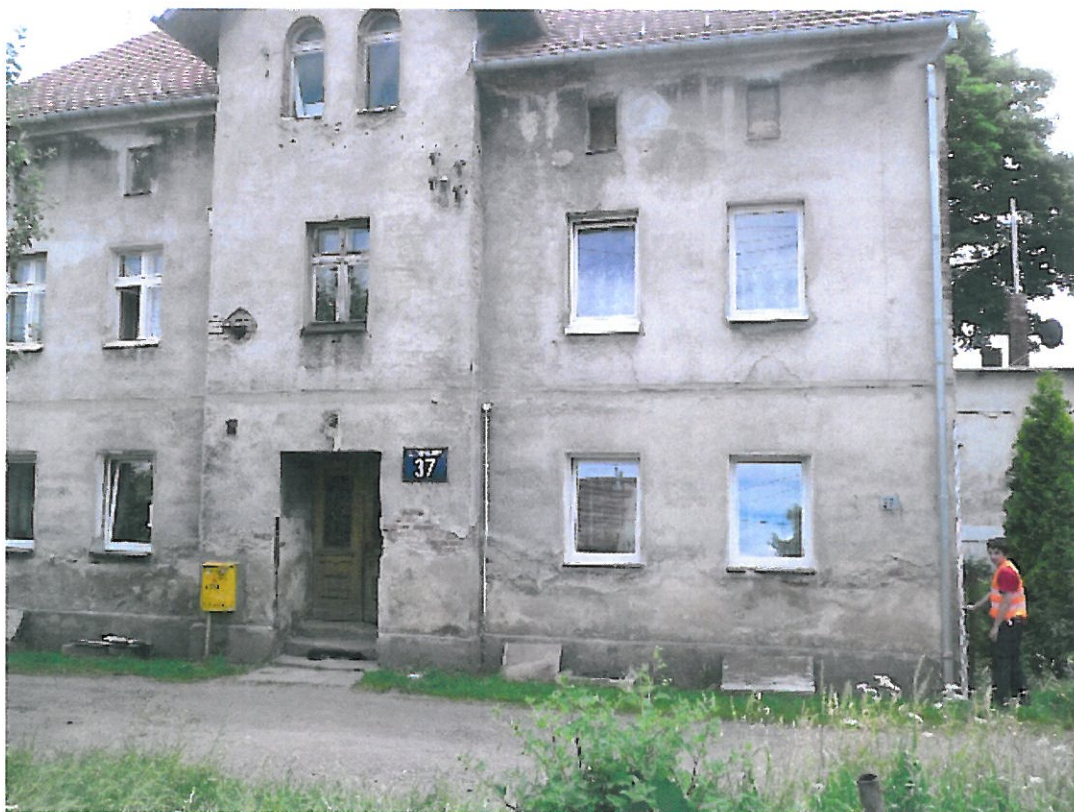
Budynek mieszkalny (elewacja frontowa)
