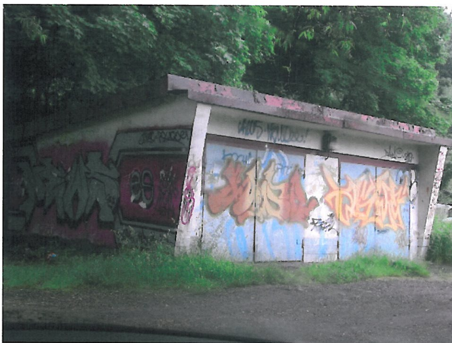
Budynki transportu i łączności – 2 szt. (NR 19÷20)
