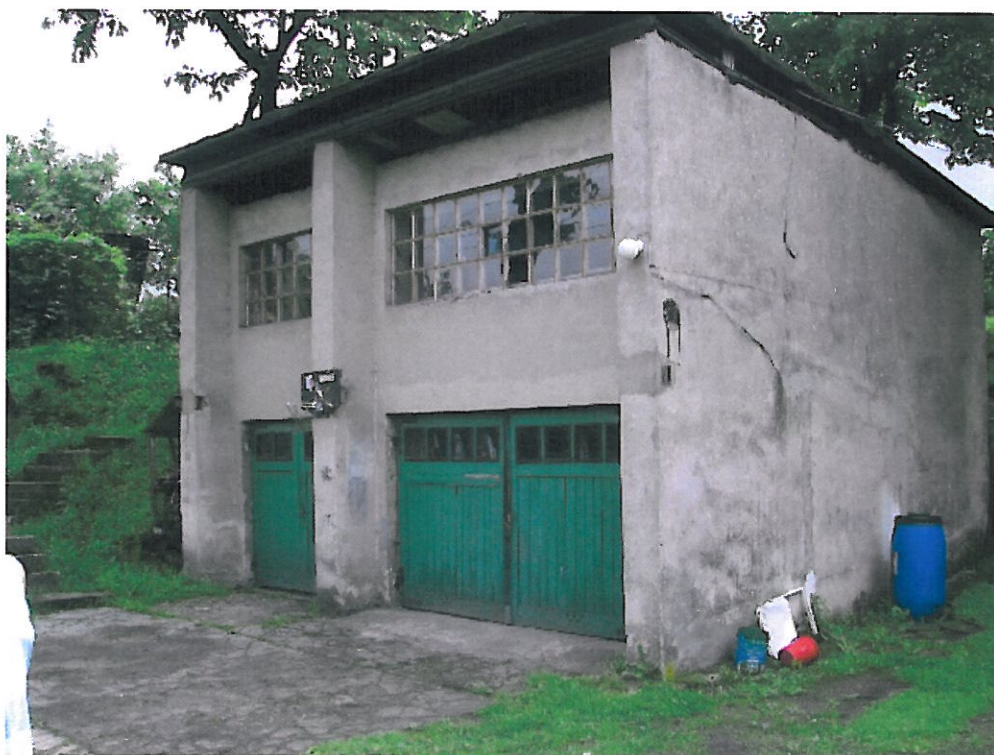
Budynek transportu i łączności (NR 143)
