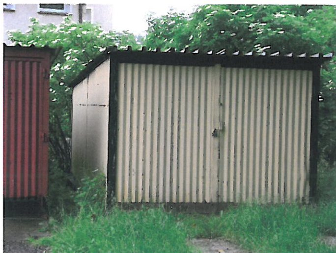
Budynek transportu i łączności (NR 69)
