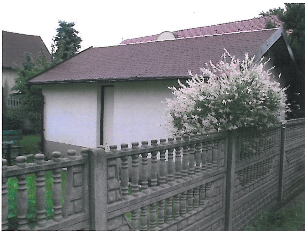
Budynek transportu i łączności (NR 89)
