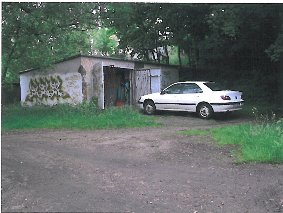
Budynki transportu i łączności – 2 szt. (NR 17÷18)
