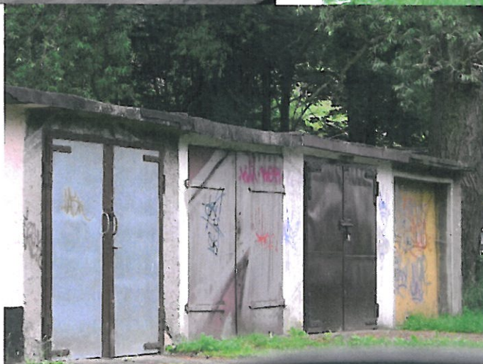
Budynki transportu i łączności – 9 szt. (NR 8÷16)
