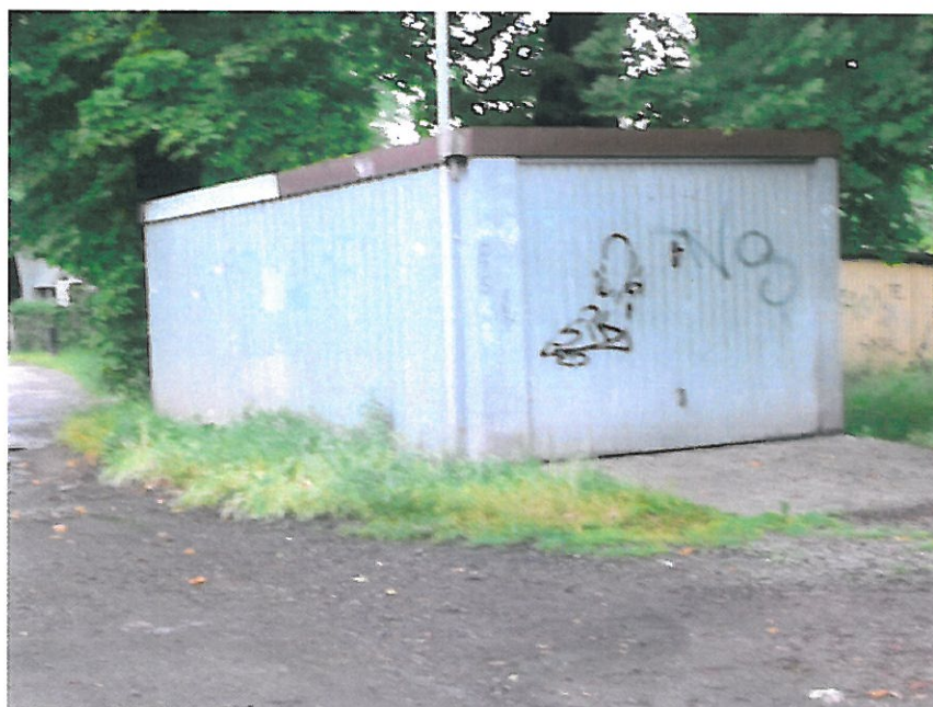
Budynek transportu i łączności (NR 73)
