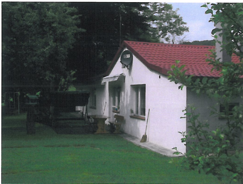
Budynek mieszkalny (NR 140)
