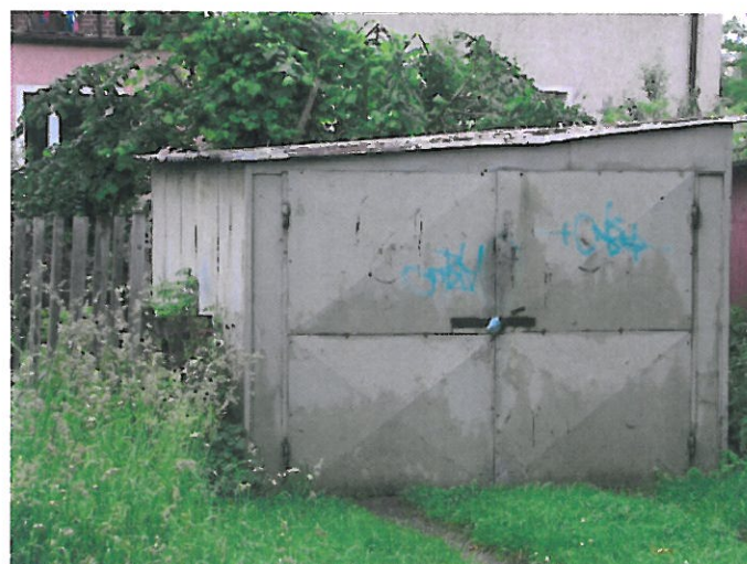
Budynek transportu i łączności (NR 71)
