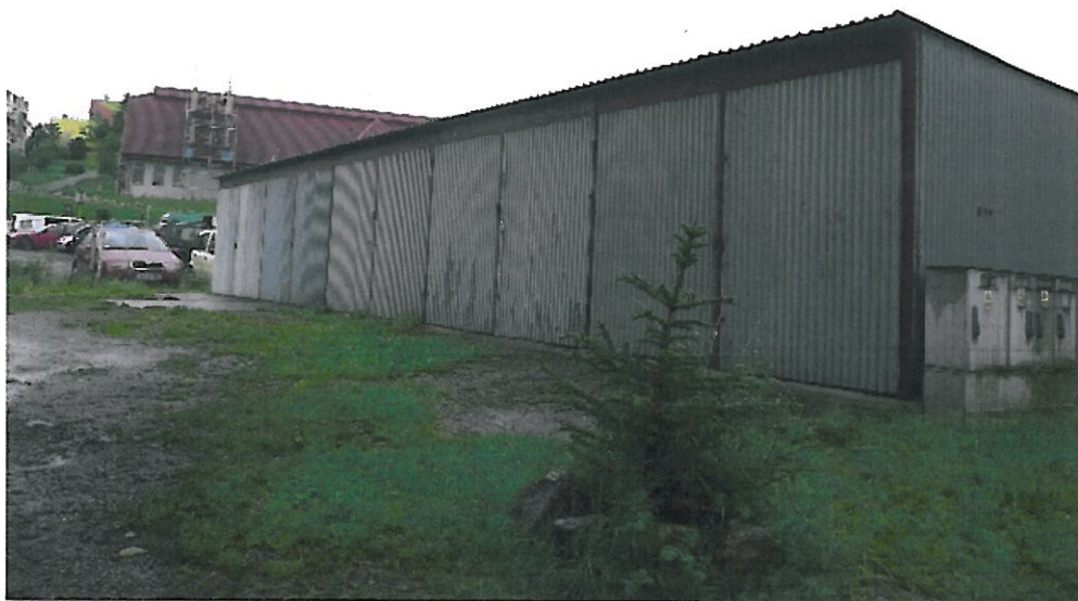
Budynki transportu i łączności – 6 szt. (NR 74÷79)
