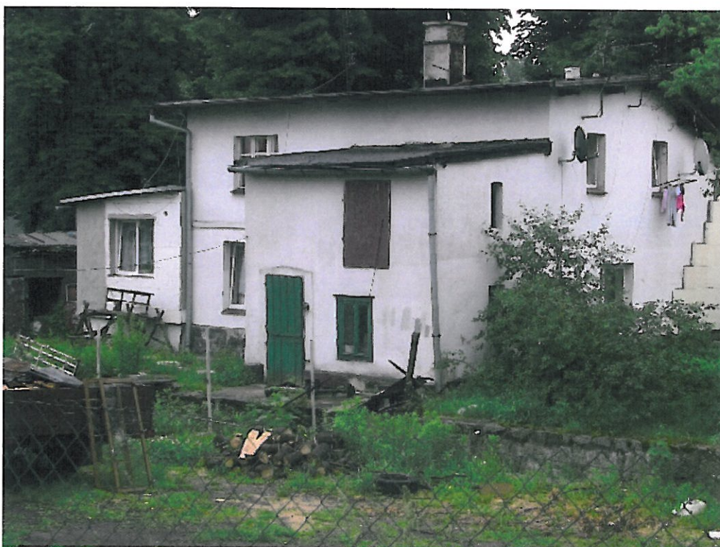
Budynek mieszkalny + 2 x budynek gospodarczy (NR 81÷83)
