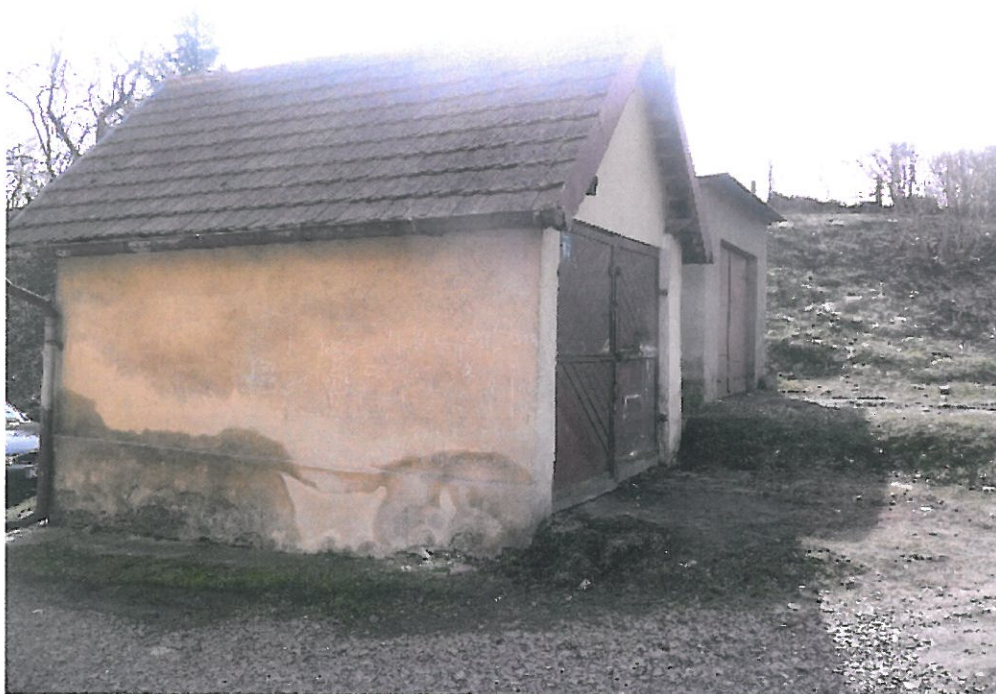
Budynki transportu i łączności – 2 szt. (NR 151÷152)
