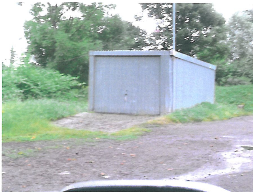
Budynek transportu i łączności (NR 72)
