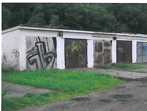
Budynki transportu i łączności – 10 szt. (NR 38÷47)
