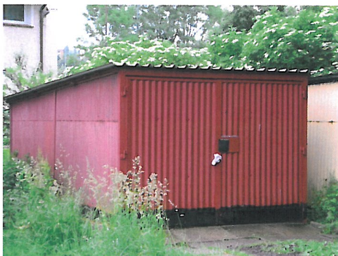
Budynek transportu i łączności (NR 70)
