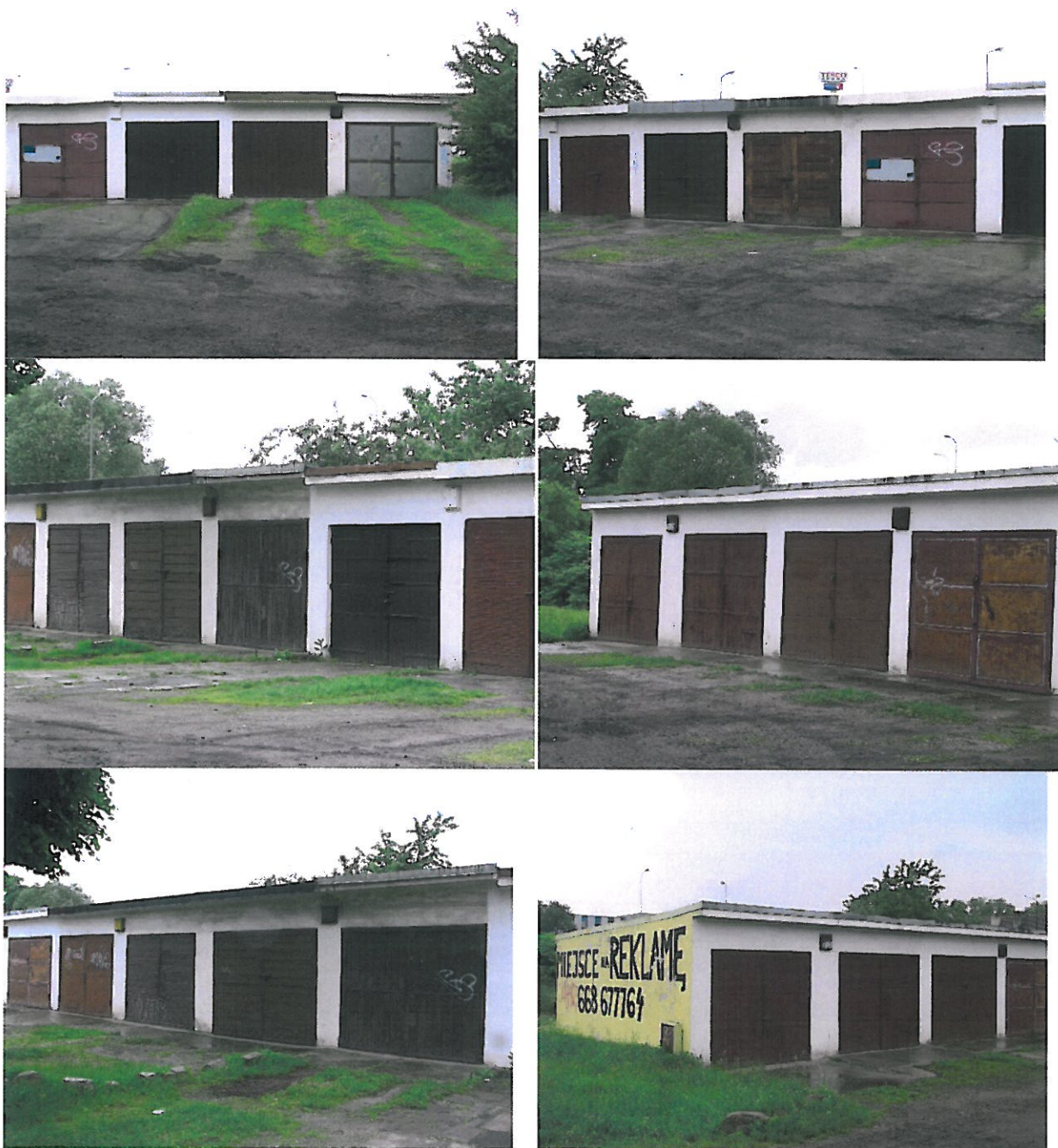
Budynki transportu i łączności – 16 szt. (NR 48÷63)
