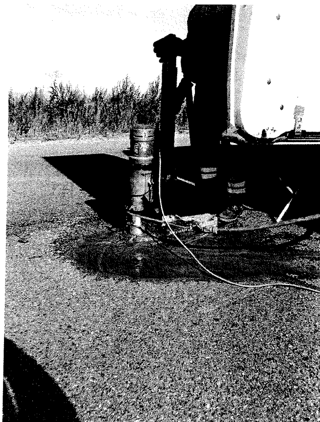
Fot. 4. Wykonywanie odwiertów
