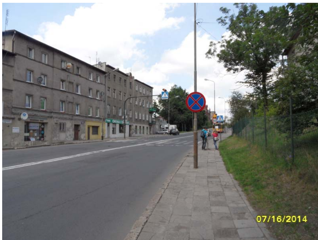
Fot.6 – Elewacja wschodnia obiektu nr 1 i 2
