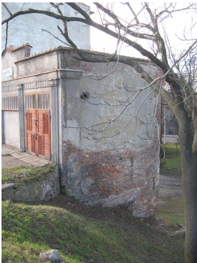
Fot.7 – Elewacja północna i wschodnia obiektu nr 3
