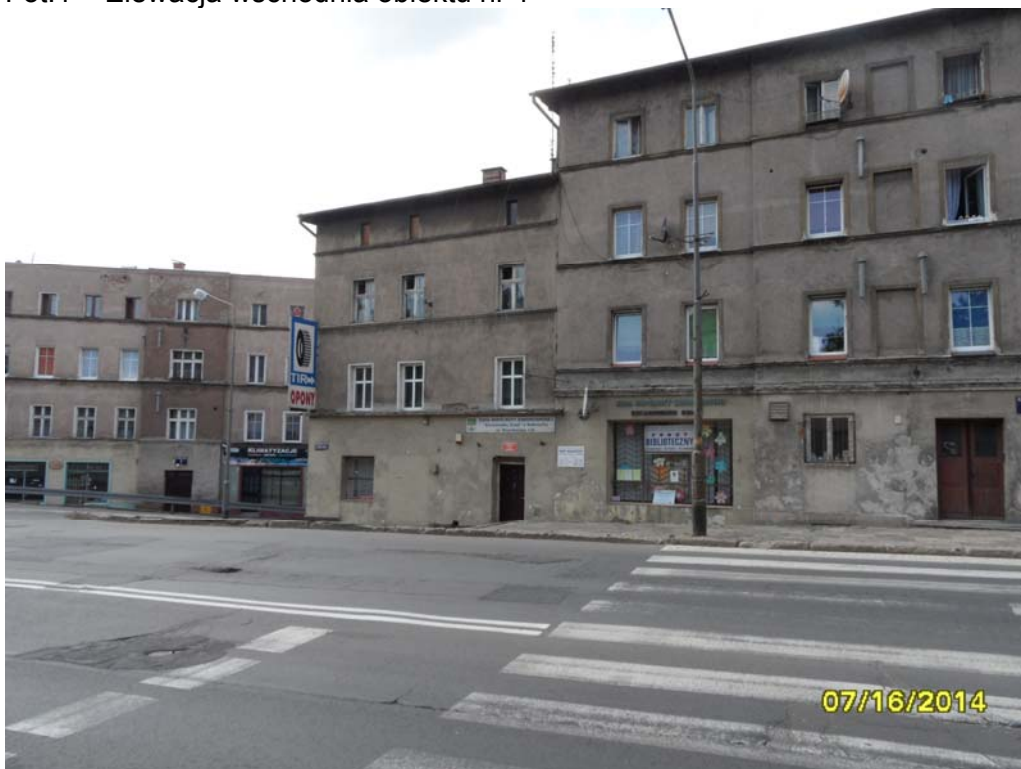
Fot.2 – Elewacja wschodnia obiektu nr 1
