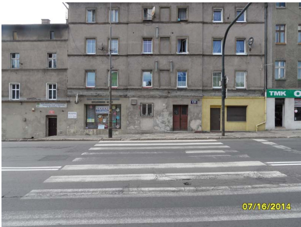
Fot.1 – Elewacja wschodnia obiektu nr 1
