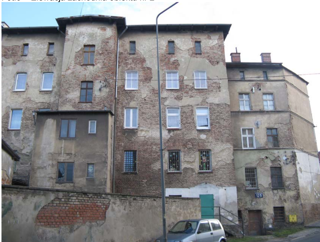
Fot.10 – Elewacja zachodnia obiektu nr 1 i 5
