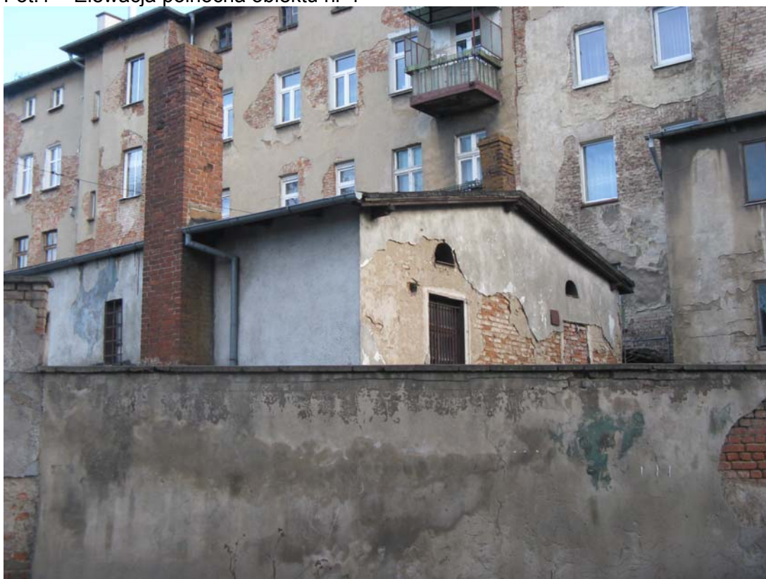
Fot.2 – Elewacja zachodnia obiektu nr 2 i 4
