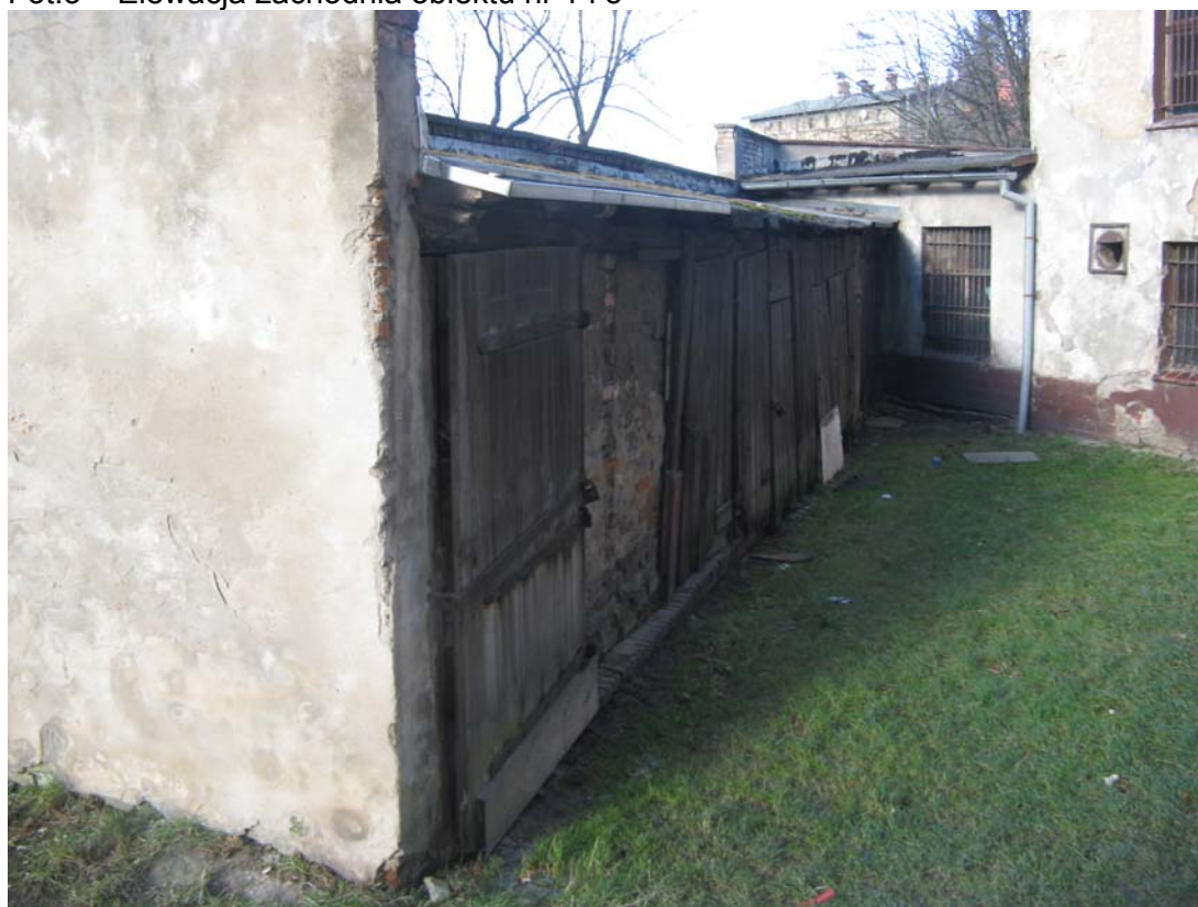
Fot.4 – Elewacja wschodnia obiektu nr 5
