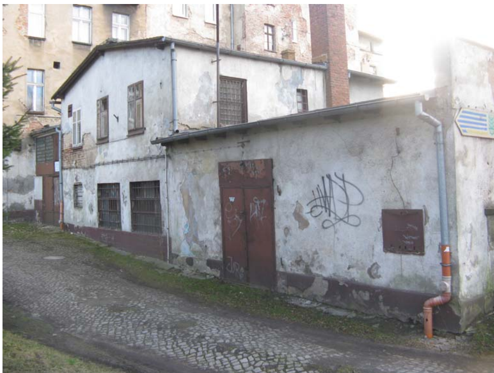
Fot.1 – Elewacja północna obiektu nr 4
