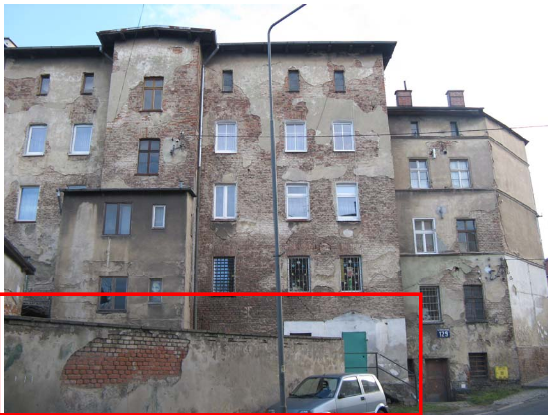
Fot.3 – Elewacja zachodnia obiektu nr 1 i 5
