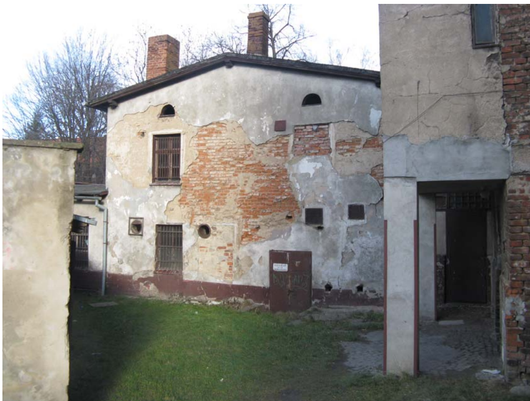
Fot.5 – Elewacja południowa obiektu nr 4
