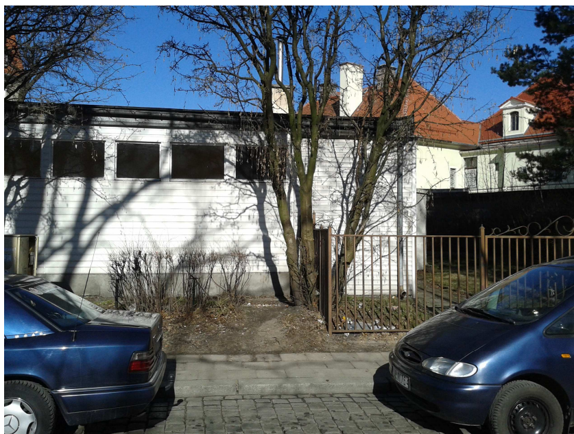
Obiekt „A” – Elewacja od strony ul. Straży Pożarnej
