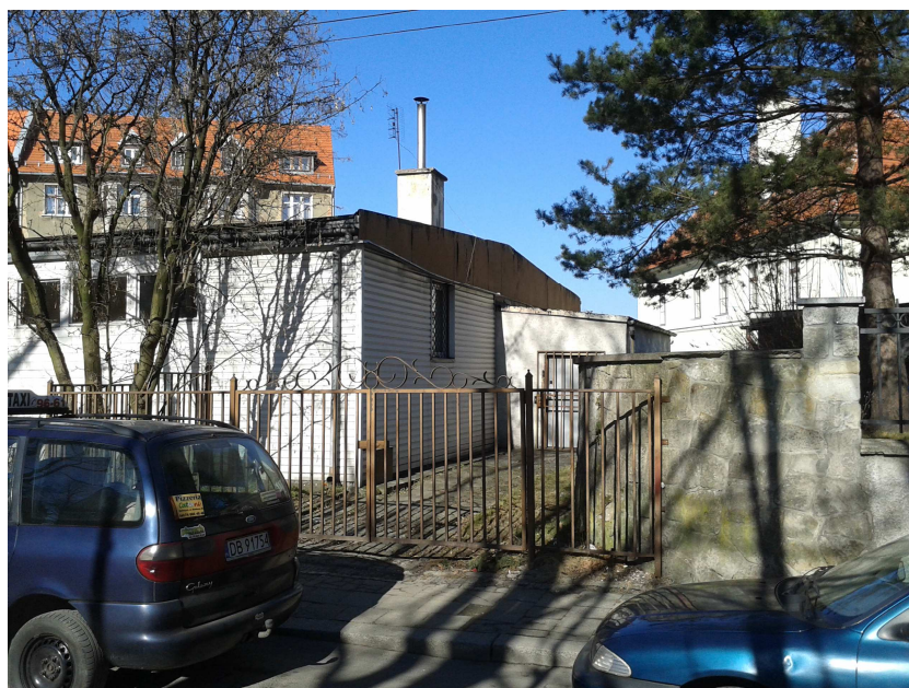
Obiekt „A” – Elewacja tylna
