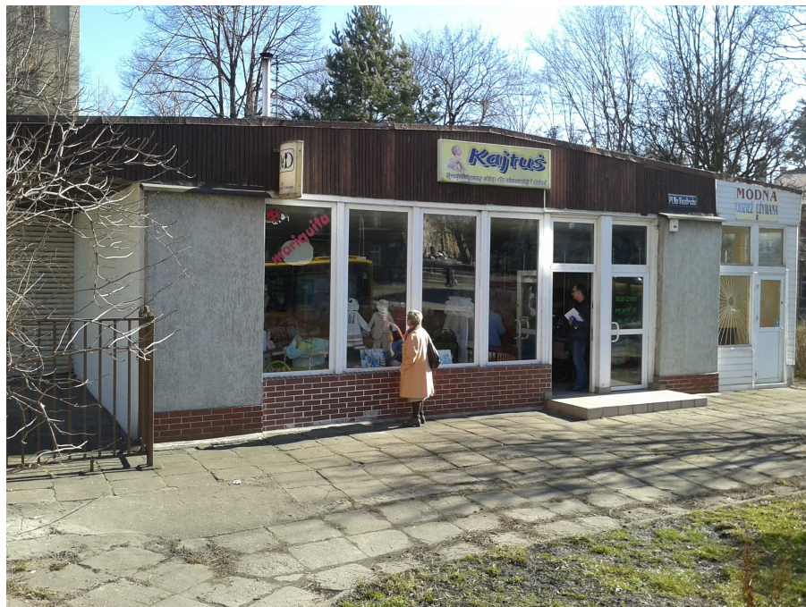
Obiekt „A” – elewacja frontowa
