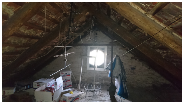
12. Konstrukcja więźby dachowej (3)
