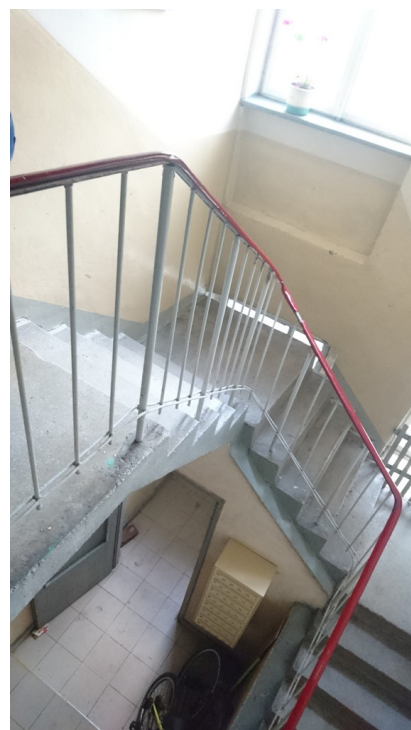
9. Klatka schodowa – widok na wejście do budynku i półpiętro
