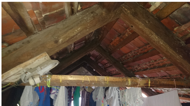
10. Konstrukcja więźby dachowej (1)
