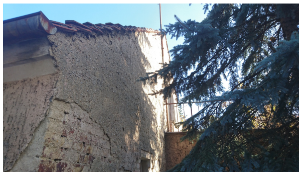
6. Widok na ścianę południową (2)
