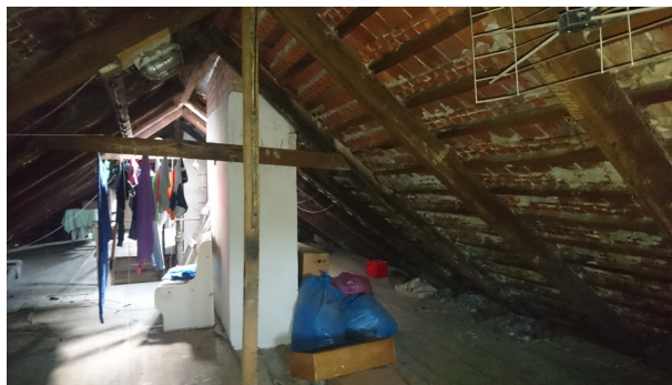
13. Konstrukcja więźby dachowej (4)
