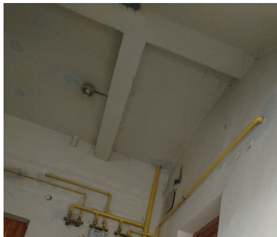
7. Klatka schodowa – układ belek stropowych (1)
