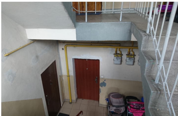
6. Klatka schodowa – widok na poziom przyziemia
