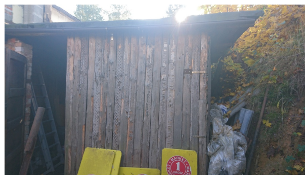
6. Szopa drewniana przyległa do ściany zachodniej
