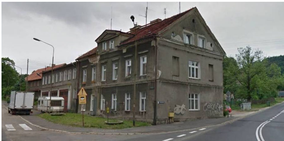
3. Widok od strony północnej
