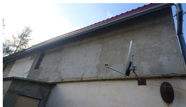
8. Widok na ścianę wschodnią po stronie północnej
