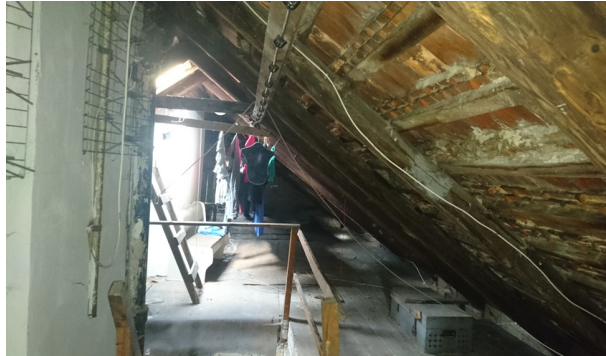
11. Konstrukcja więźby dachowej (2)
