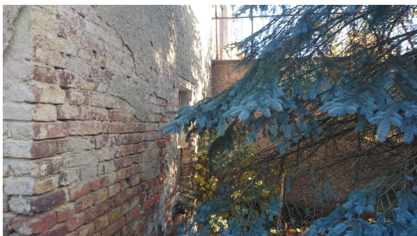
5. Widok na ścianę południową (1)
