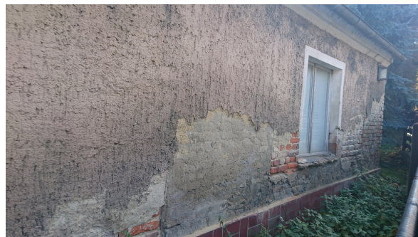
4. Widok na ścianę zachodnią po stronie południowej
