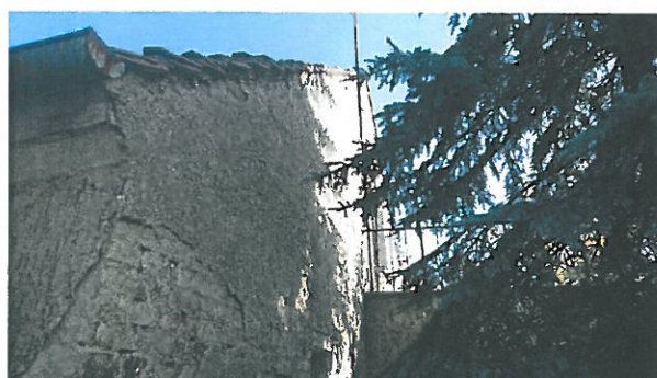
6. Widok na ścianę południową (2)
