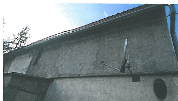
8. Widok na ścianę wschodnią po stronie północnej
