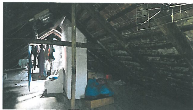
13. Konstrukcja więźby dachowej (4)
