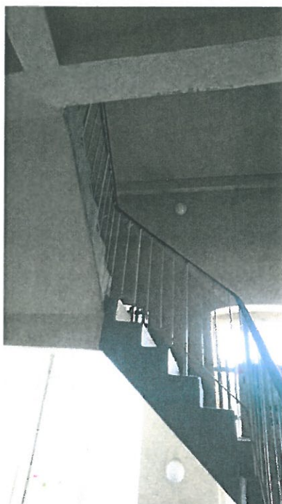
8. Klatka schodowa – układ belek stropowych (2)
