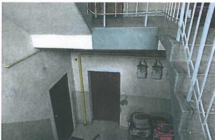
6. Klatka schodowa – widok na poziom przyziemia
