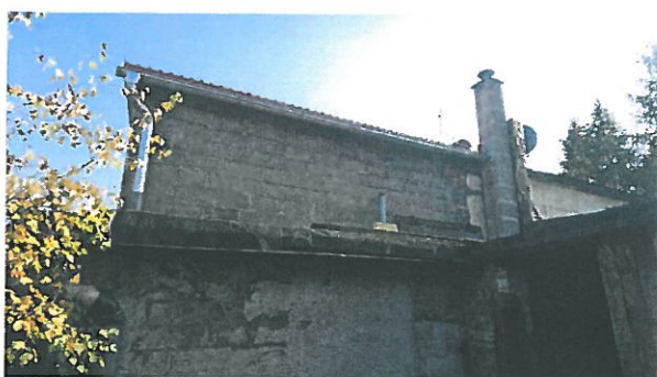
5. Widok na ścianę zachodnią po stronie północnej
