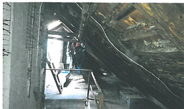
11. Konstrukcja więźby dachowej (2)
