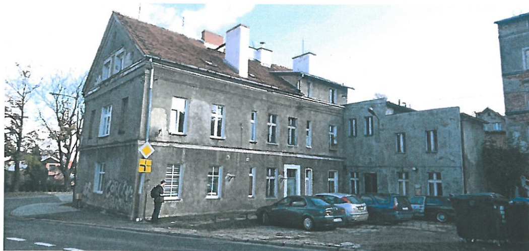
5. Widok od strony zachodnia
