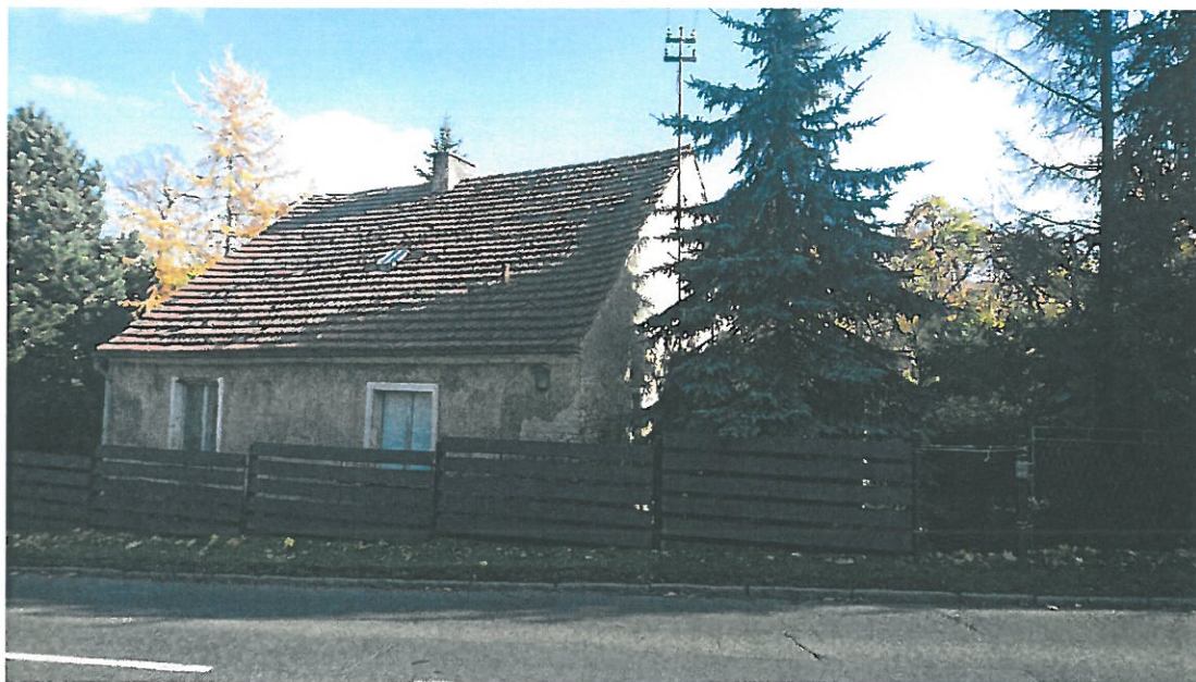
2. Widok od strony południowo - zachodniej
