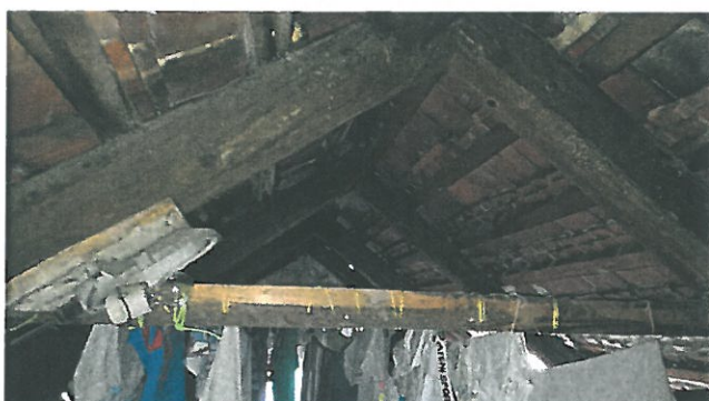
10. Konstrukcja więźby dachowej (1)
