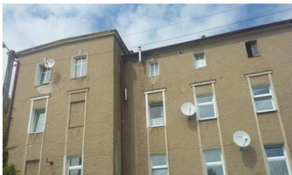
Rycina 30 Skontrolowany budynek przy ul. Kolejowej 21 Boguszów Gorce
