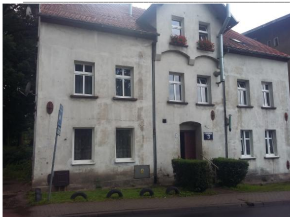
Rycina 40 Skontrolowany budynek przy ul. Kosteckiego 3 Wałbrzych
