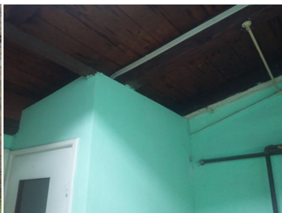
Rycina 29 Skontrolowane wnętrze budynku przy ul. Dworcowej 3 Boguszów Gorce
