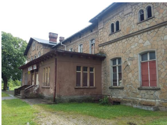
Rycina 28 Skontrolowany nieużytkowany budynek dworca PKP Boguszów Gorce
