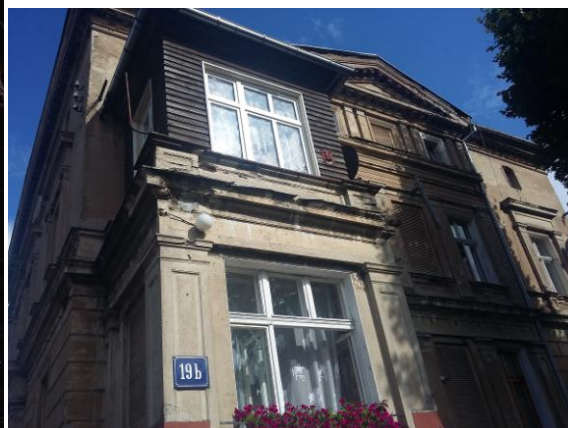
Rycina 43 Skontrolowany budynek ul. Gen. Andersa 19b Wałbrzych
