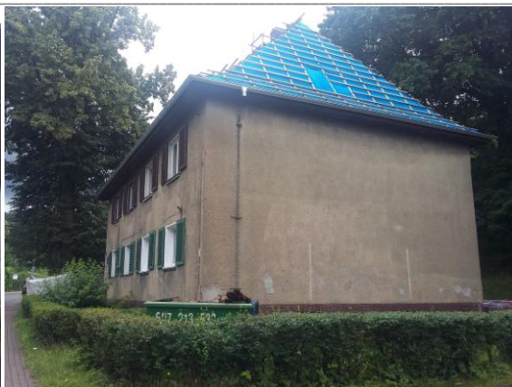
Rycina 41 Skontrolowany budynek przy ul. Kosteckiego 3a Wałbrzych – wymiana dachu
