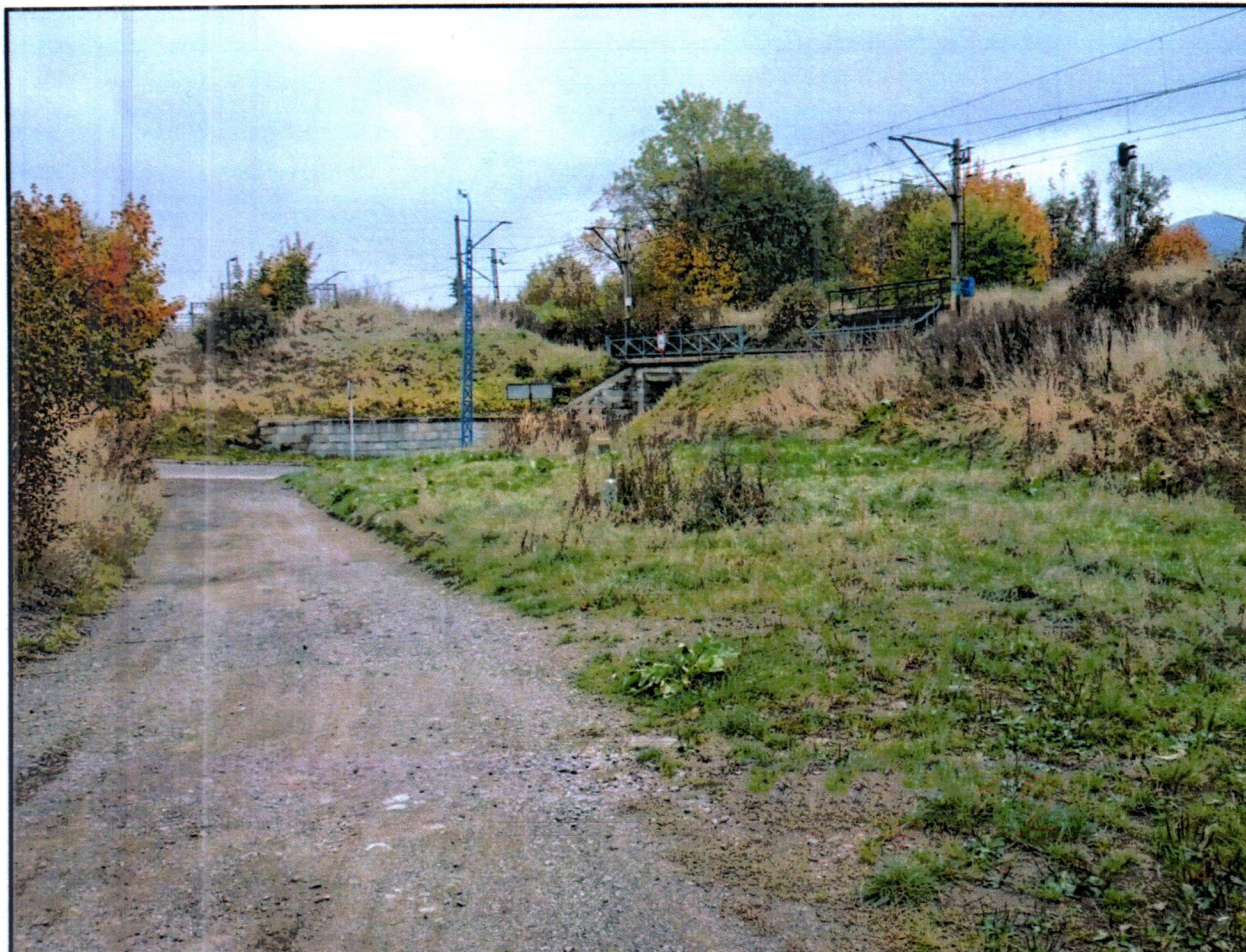
Boguszów-Gorce, wiadukt kolejowy przy ul. Karola Świerczewskiego
