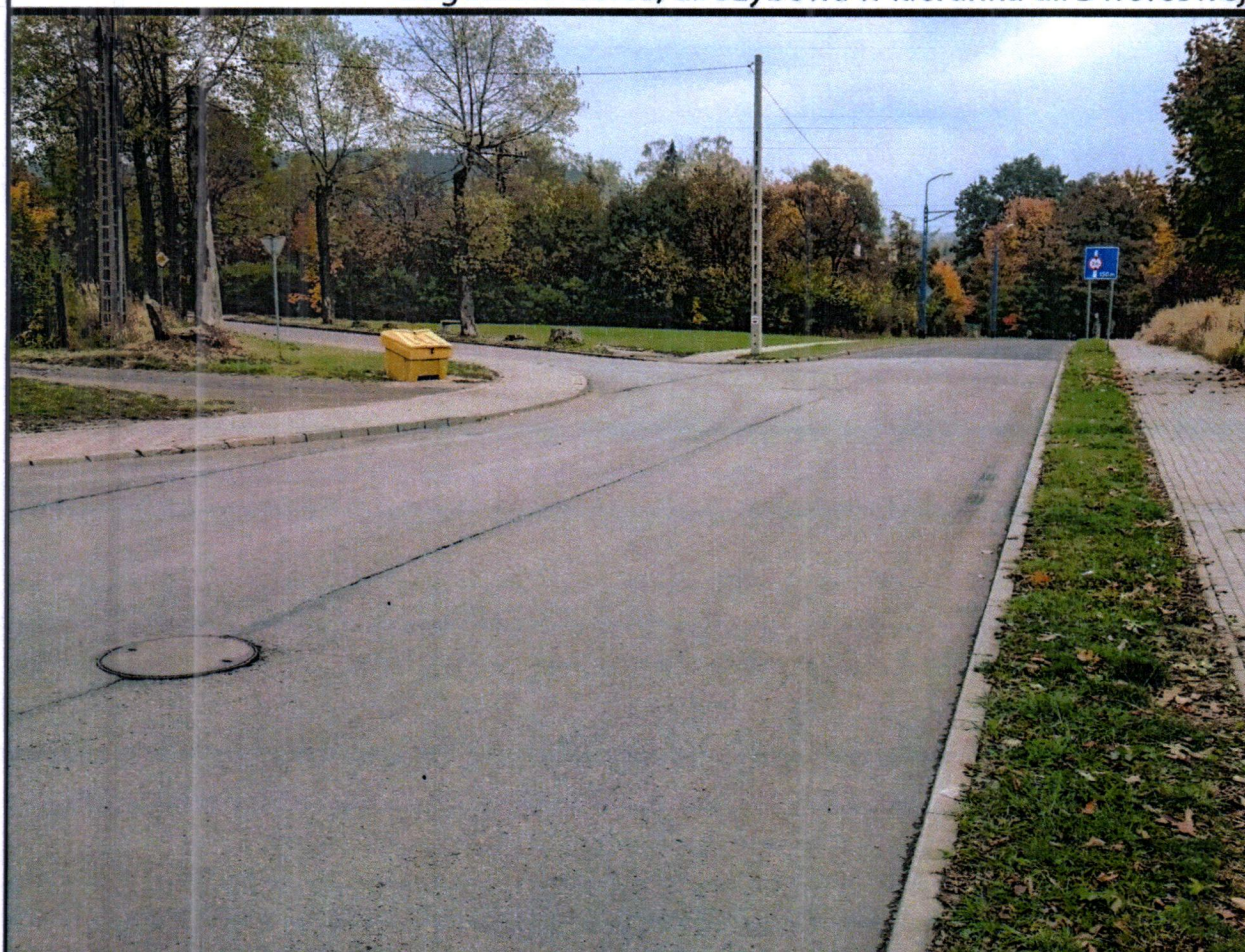
Boguszów-Gorce, skrzyżowanie ul. Dworcowej i Szybowej
